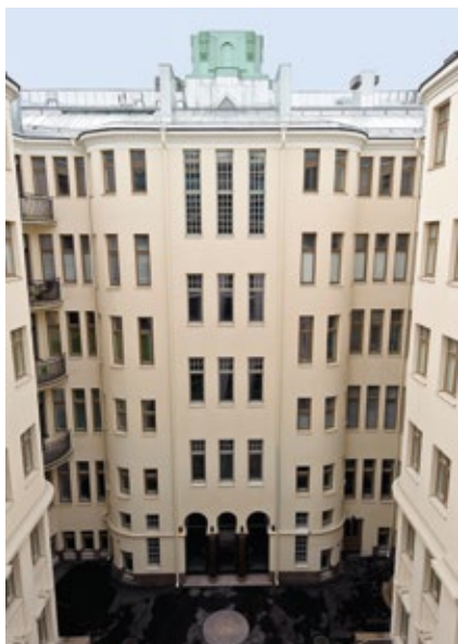
Mikonkatu 11 sijaitsee keskellä Kluuvin ruhjetta. Perustusten huonokuntoisten puupaalujen vahvistaminen oli sekä suunnittelulle että toteutukselle vaativa tehtävä.
