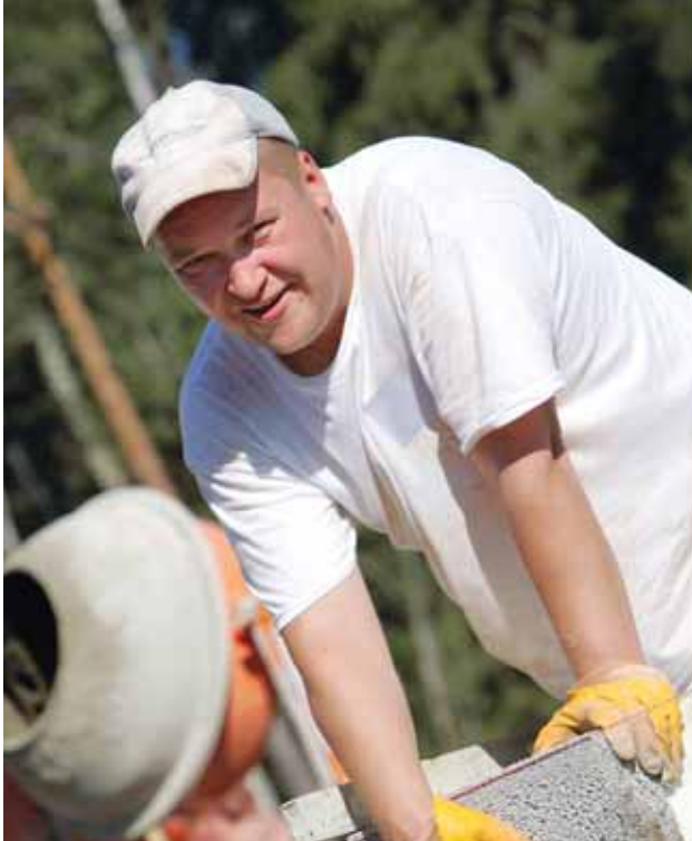
MUURARI ARSI MUSTONEN JATULINTARHOJEN TYÖMAALLA ELOKUUSSA.
