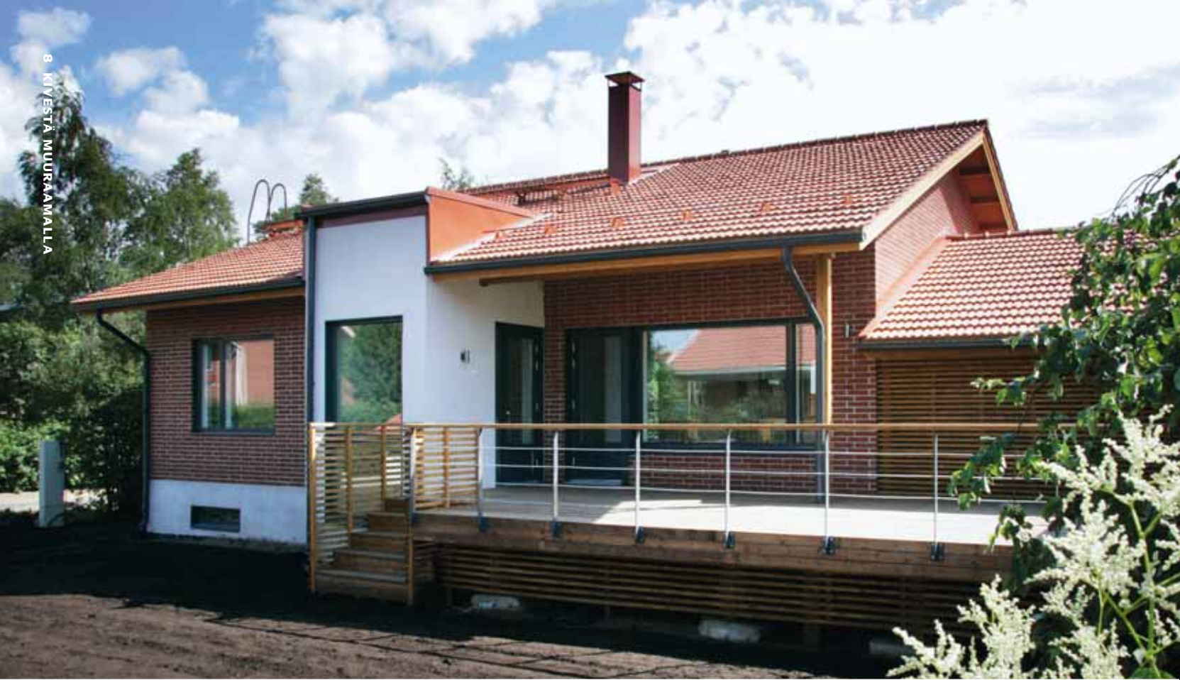
PUNAISESTA KARHEASTA TIILESTÄ MUURATTUJA JULKISIVUJA RYTMITTÄVÄT VAALEAT RAPATUT OSAT. NIISSÄ ON MAKUHUONEEN IKKUNAN ALAPUOLELLA KELLARIKERROKSEN PERISKOOPPI-IKKUNA.
