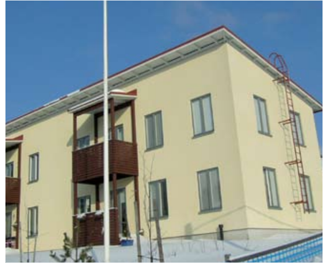
NORMAALI VILLALLA ERISTETTY BETONIELEMENTTITALO ON PINNOITETTU SERPOMIN OHUTRAPPAUKSELLE, SERPO-LAASTEILLA JA PINNOITTEILLA.
