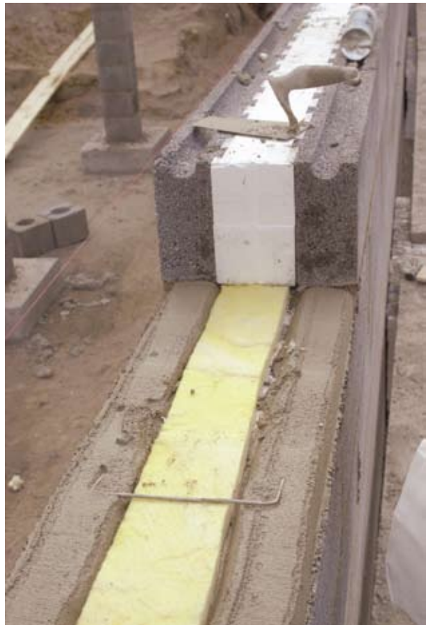
Kuva 4.13. Rakosaumaan on asennettu mineraalivillakaista ja muurausside.
