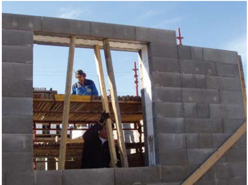
Kuva 4.26. Ikkuna-aukon ylityspalkin tukeminen valua varten.
