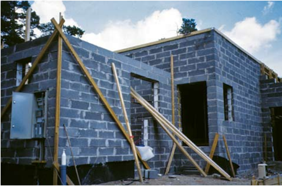
Kuva 4.25. Kevytsoraharkkotalo rakenteilla.
