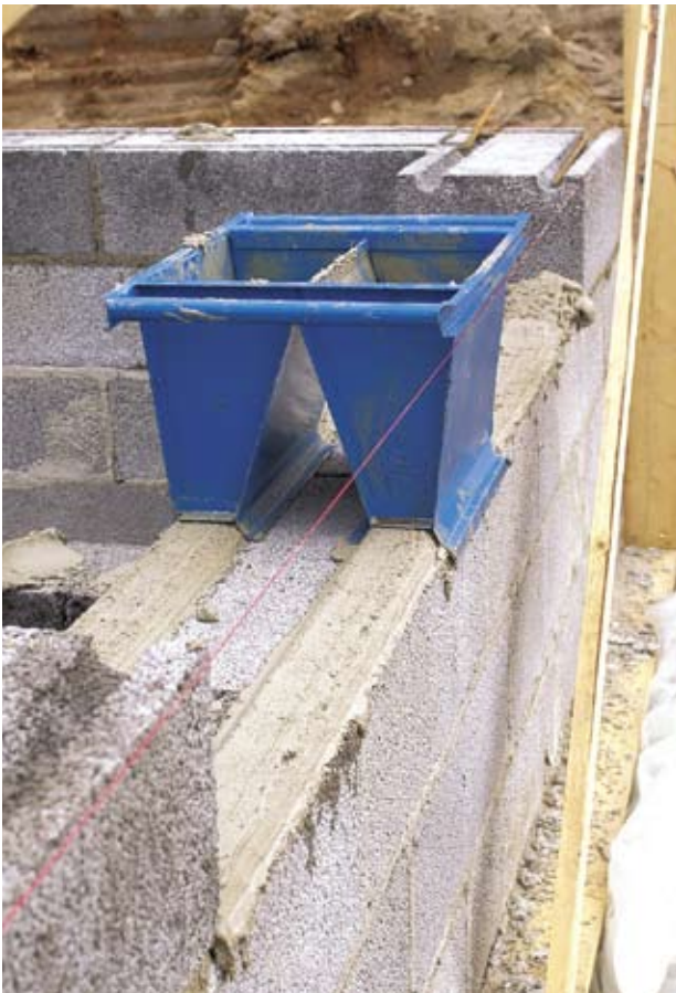
Kuva 4.12. Muurauskelkalla laastikerroksesta tulee tasainen.
