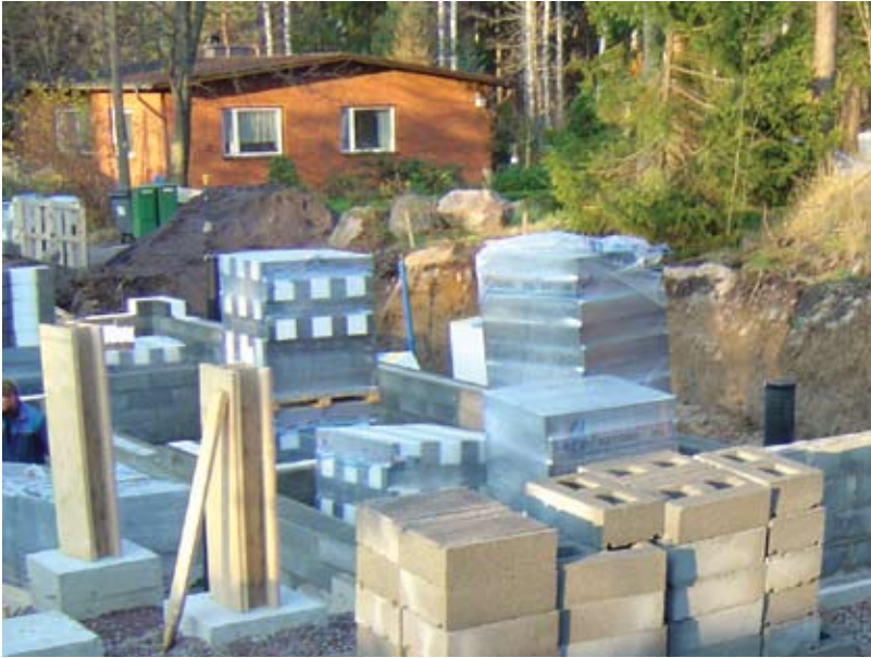
Kuva 3.20. Harkkolavat kannattaa nostaa kuormasta perustusten läheisyyteen käsin siirtelyn vähentämiseksi.
