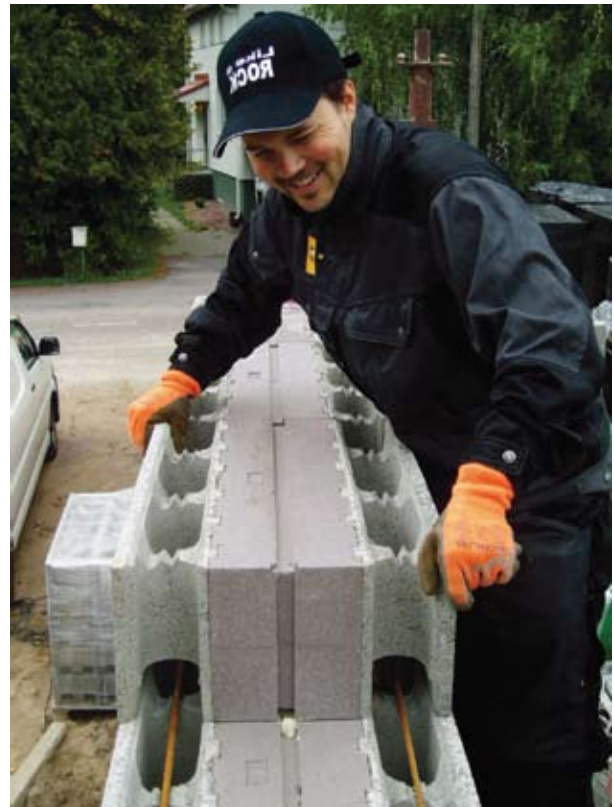
Kuva 2.11. Valettavien betoniharkkojen ladontaa. Vaakaraudoite asennetaan valuharkossa olevaan uraan.
