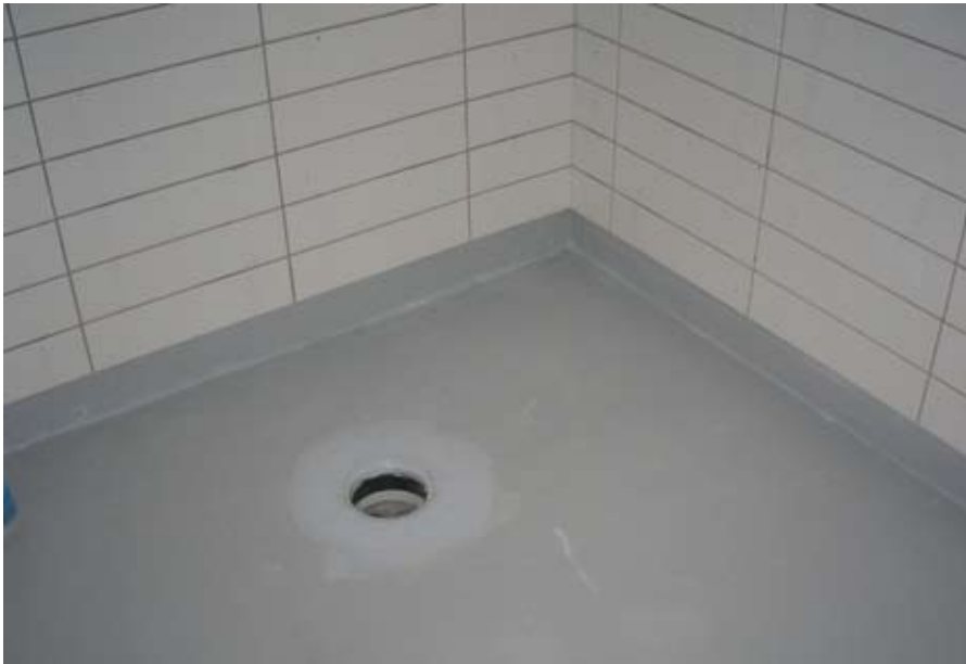
Kuva 4.39. Lattian vedeneristys valmiina laatoitusta varten.
