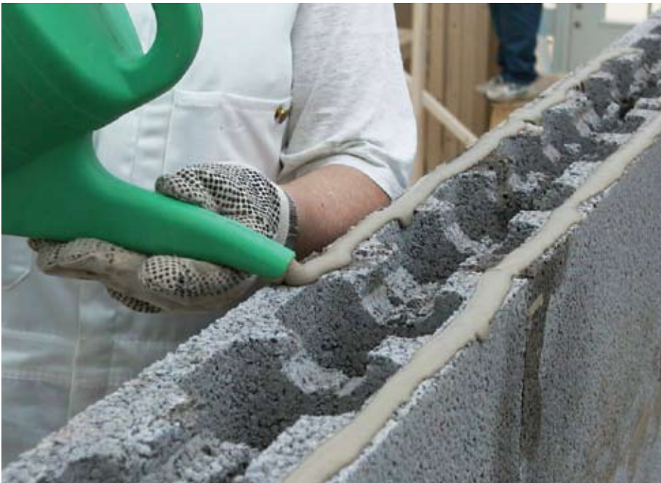
Kuva 2.14. Liimattava betoniharkko.
