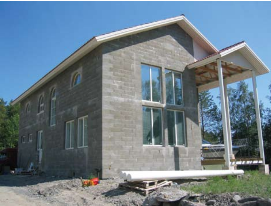
Kuva 3.11. Harkkorakentaminen on paikallarakentamista. Toteutusmuodon valinnalla voidaan vaikuttaa rakennushankkeeseen ryhtyvän ajankäyttöön ja kustannuksiin.
