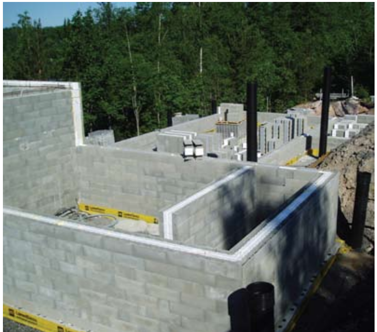
Kuva 4.15. Anturamuotin päälle ladottu kellarin valuharkkoseinä.
