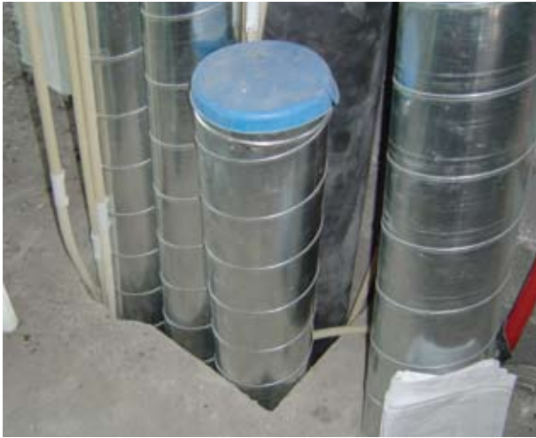
Kuva 4.36. Ilmanvaihto-, vesi- ja sähköputkitusten läpivienti välipohjasta.
