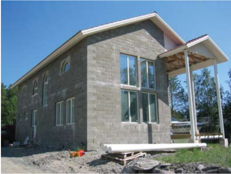
Kuva 2.10. Rakenteilla oleva betoniharkkotalo.
