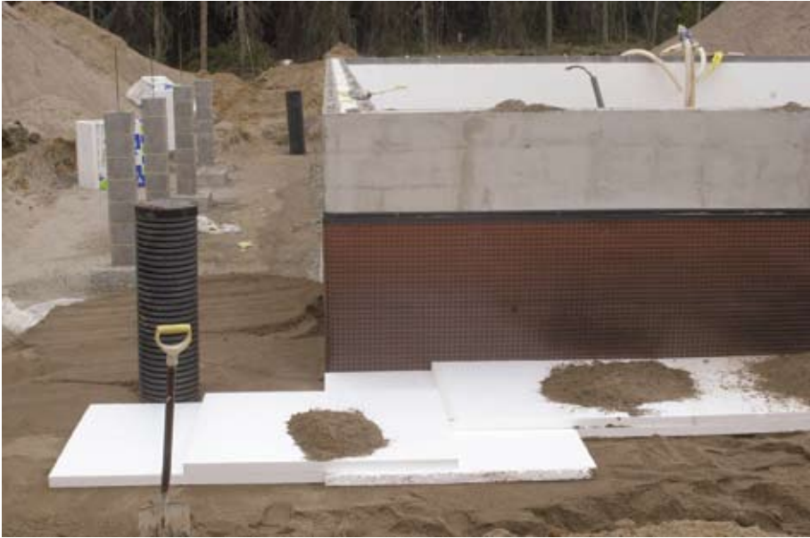
Kuva 4.22. Perustusten routasuojauksen asennusta pientalotyömaalla.
