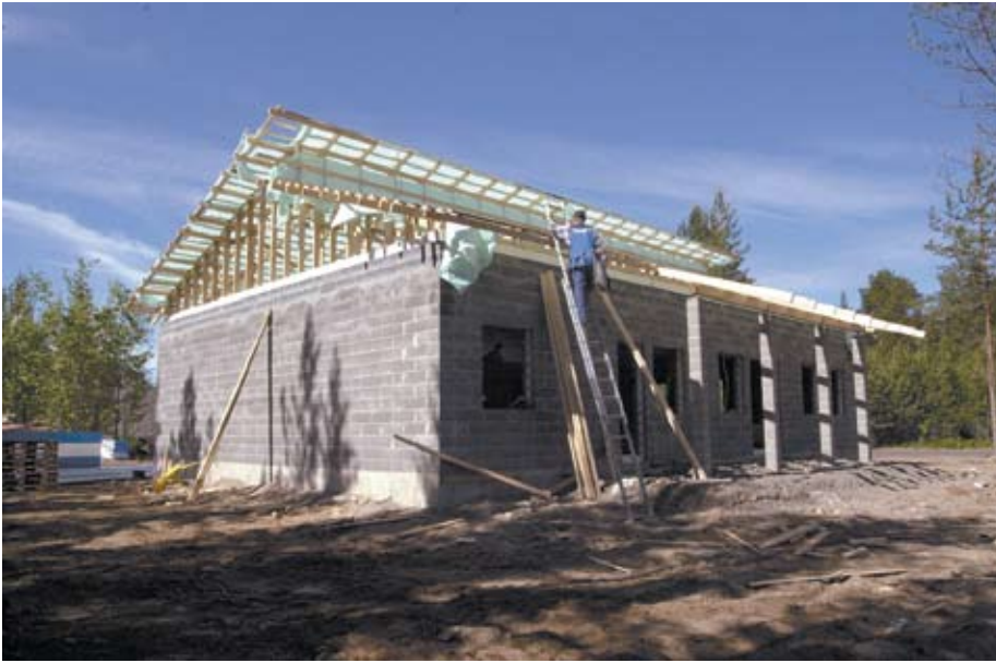
Kuva 4.33. Puurakenteinen yläpohja on yleinen harkkotaloissa.
