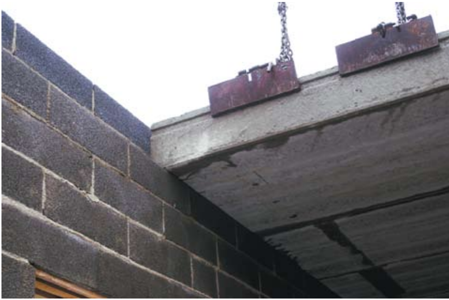
Kuva 4.32. Ontelolaatan asennus kevytsoraharkkoseinän päälle.
