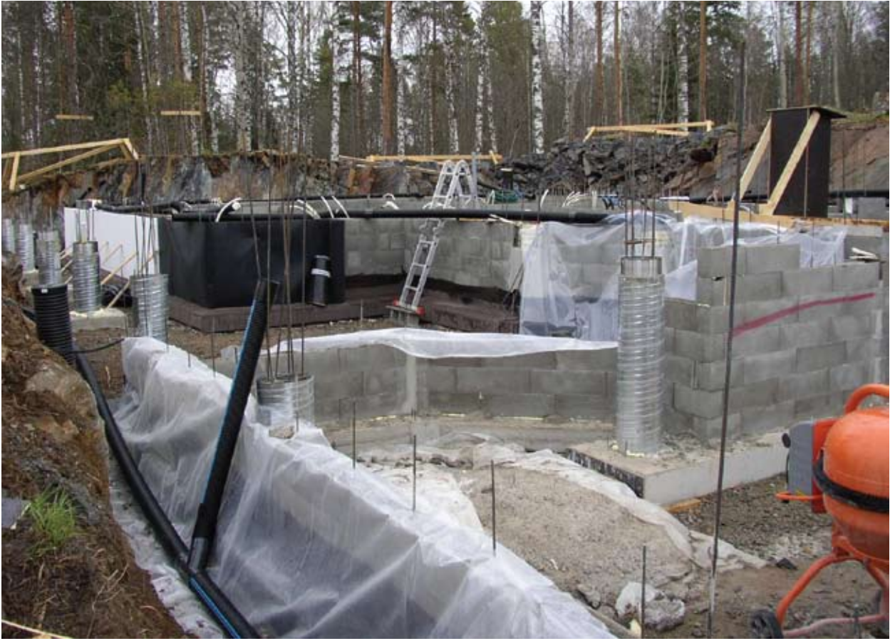
Kuva 4.16. Valu voidaan peittää muovilla liian nopean kuivumisen estämiseksi.
