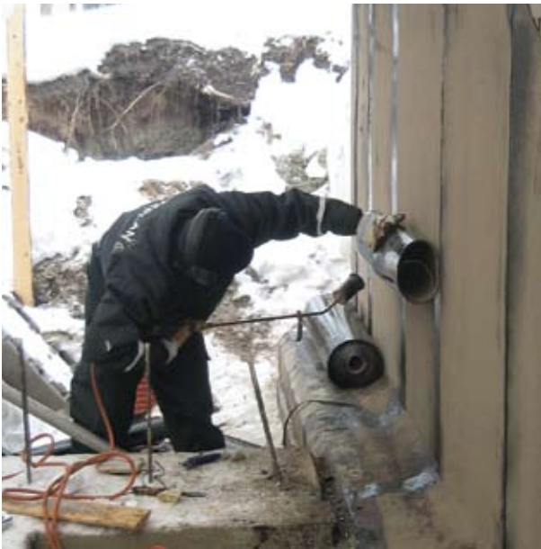
Kuva 4.20. Perusmuurin vedeneristystä bitumikermeillä.
