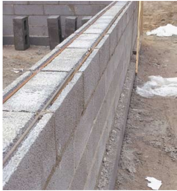
Kuva 4.10. Kevytsoraharkkoperusmuuri ja raudoite
