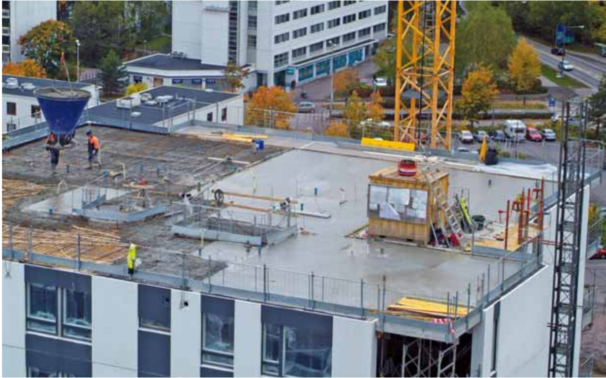
Kuva 2.10. Massiivinen välipohja varmistaa hyvän kerrosten välisen ääneneristävyyden.
