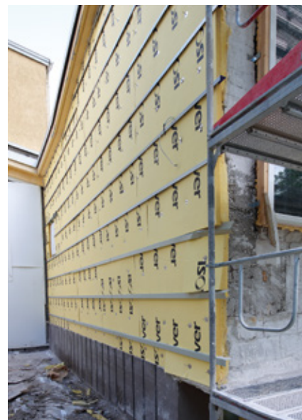
SerpoVent-levyrappauksen yhteydessä asennettiin 170 millin lisälämmöneristys. Seinän paksuus ei silti kasvanut, mikä oli museoviraston vaatimus.
