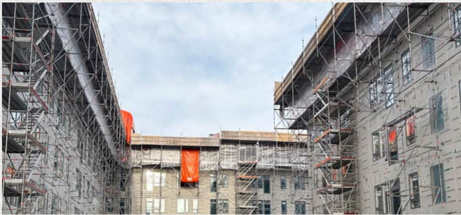
Rakennuksen julkisivu toteutetaan levyrappausjärjestelmällä.
