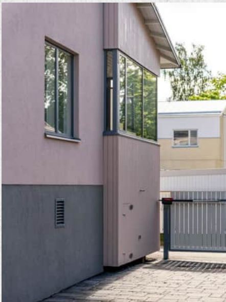
Pienkerrostalon runko on toteutettu harkkorakenteisena.
