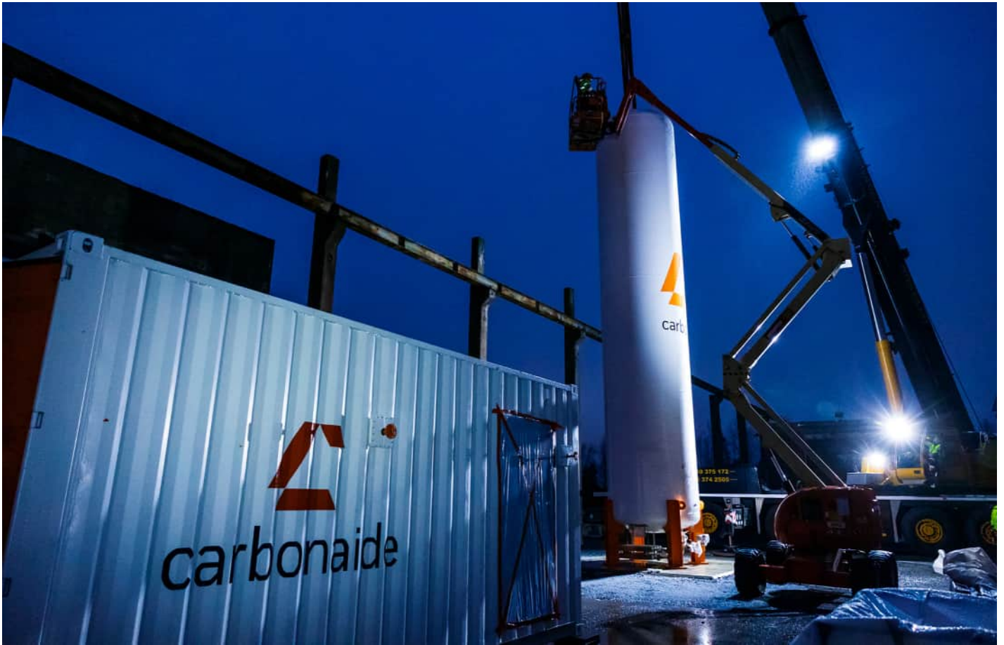
Joensuun Carbonaide-laitoksen rakennustyöt tehtiin talvella 2025.
