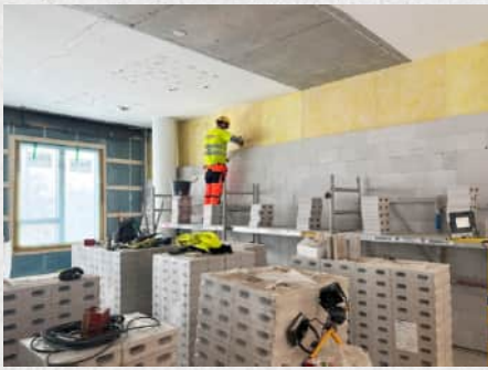
Kierrätettyjen Kahi-tiilien muuraus tapahtuu samoin kuin uusien.
