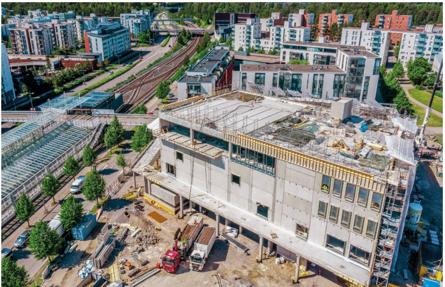
Vuosaaren lukion työmaalla käytettiin pumpattavaa Leca-sorabetonia vajaan 1 400 neliön verran.
