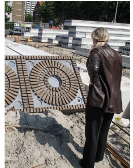
Marlies Rohmer tutkii työmaalla tehtaalta tulleita elementtejä.
